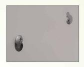
Particolare del fissaggio del disco mediante fori asolati
